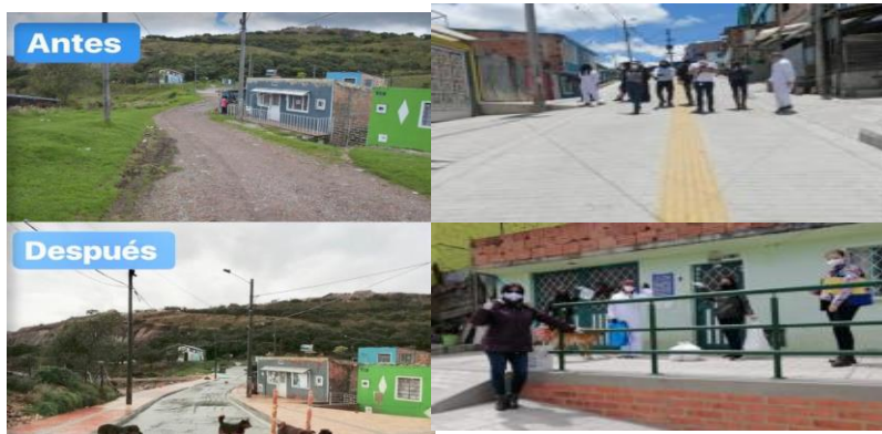
Registro fotográfico de las Intervenciones en el marco del Contrato No. 584 de 2016
