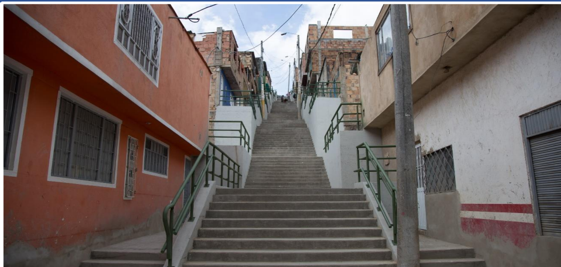
La ingeniería Civil desarrollada en la construcción de las escaleras prolongadas en la localidad de Usme en el barrio Compostela.
