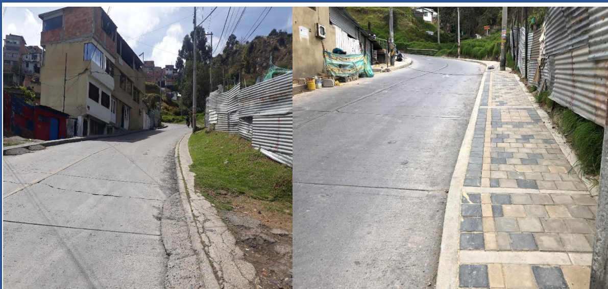
Las vías construidas en Villa Nidya en la localidad de Usaquén
