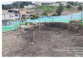
CIV: 4006358 Intervención: Calzada y Andenes
