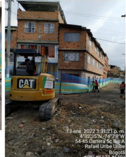
CIV: 18006137 - 9161 Intervención: Calzada y Andenes
