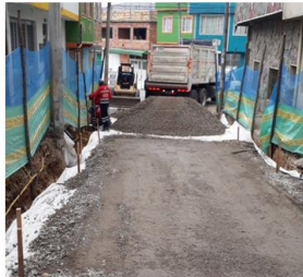
CIV: 18005694 - 5744 Intervención: Calzada y Andenes
